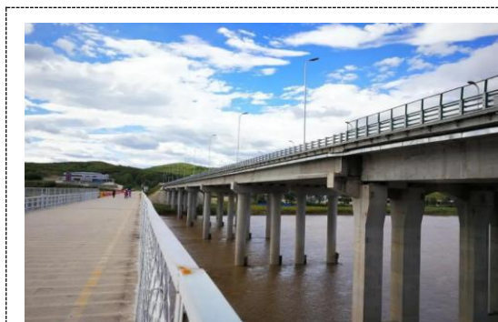
圈河口岸跨境公路新旧大桥
